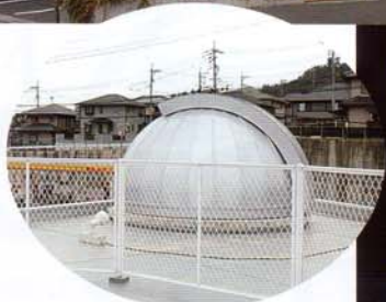
屋上・天体ドーム
